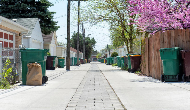
Un callejón ecológico del MWRD en Berwyn filtra lentamente el agua al suelo.
