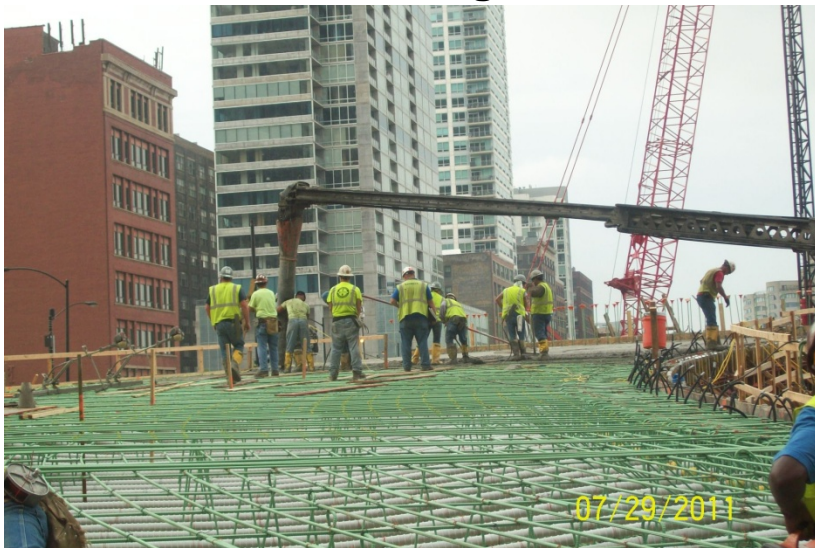
Tunnel E Roof Pour
